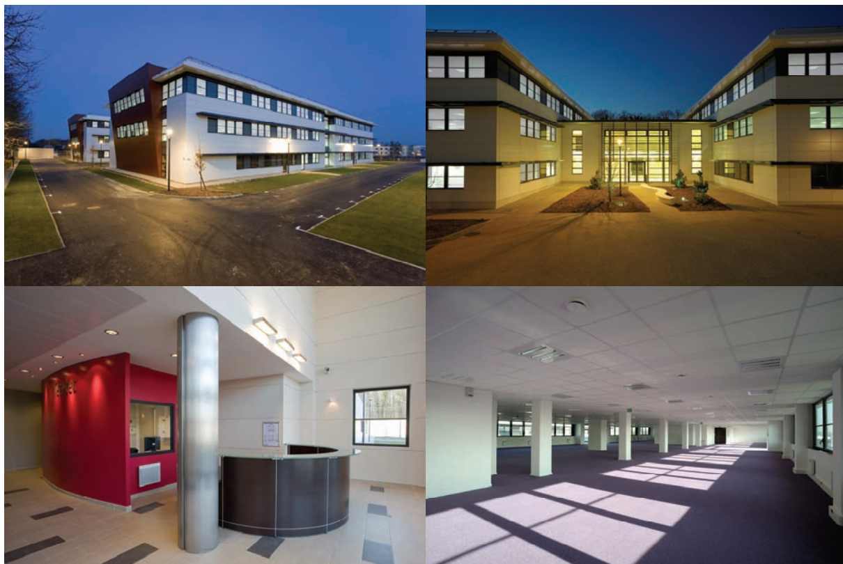
Une réalisation Bouygues Batiment Ile-de-France, Sodearif / Brezillon / Ouvrages Publics. Architecte : Groupe Synthese / 2AMT. Photos : Franck Renoir
