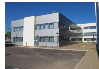
Bureaux du TGCC
