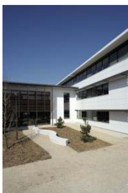
Face au Très Grand Centre de calcul du CEA, les bâtiments du campus Ter@tec
